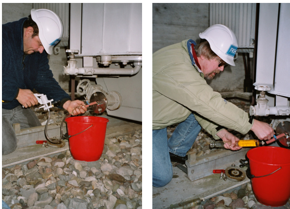
Après la connexion et la mise sous vide d'un adaptateur, un échantillon est prélevé avec une seringue en verre pour l'analyse des gaz dissous
