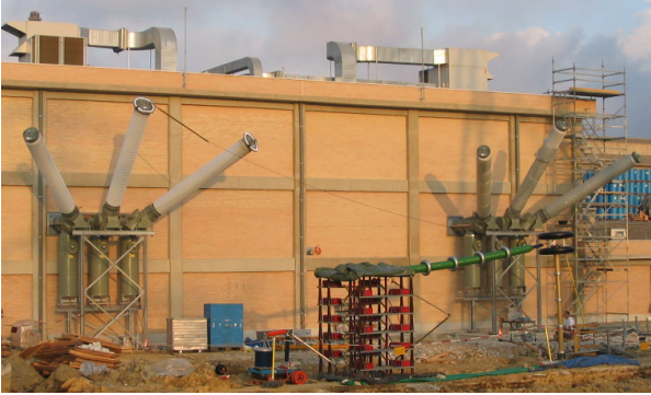
Générateur de choc de la FKH lors de l'essai d'un poste 420 kV avec ondes oscillantes
