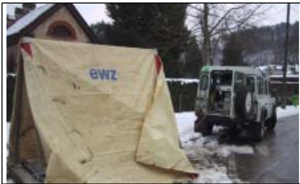
Bild 10 Messaufbau oberhalb des Muffenschachts
